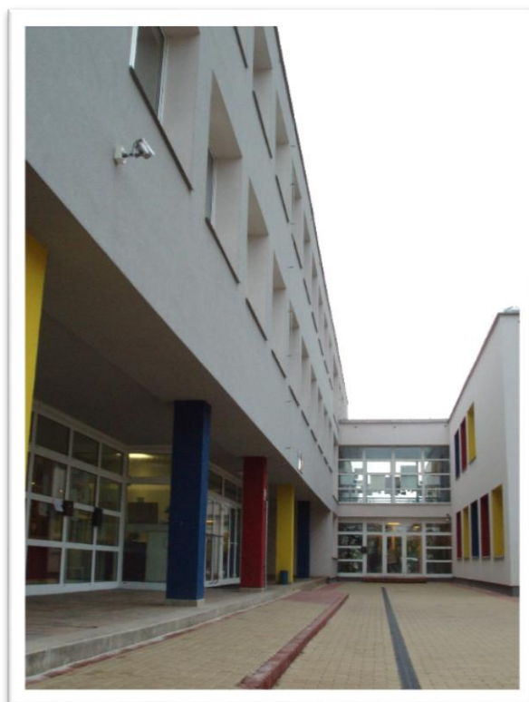
Obrázek č. 1 - Budova školy
